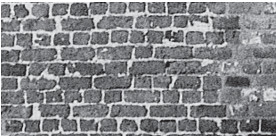
Het metselwerk is een mengeling van kruisverband en staand verband
