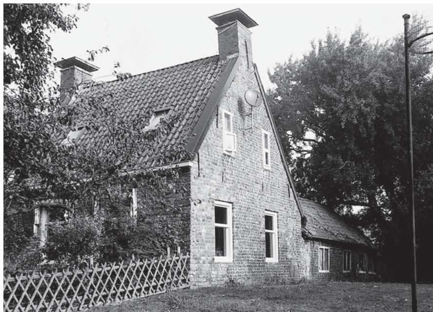
De voorgevel vanuit het zuiden gefotografeerd, rechts de uitgebouwde melkkelder
